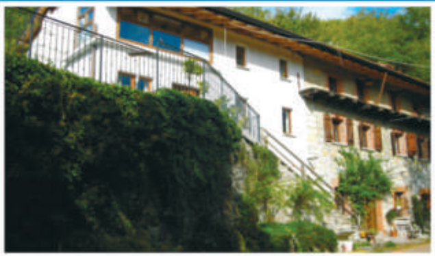
FAEDIS favolosa casa rustica indipendente, restaurata in bioedilizia, pietra e travi a vista, 1.700 mq di frutteto, da vedere! Rif. 08-01513 SIRIO CIVIDALE 0432 734317
