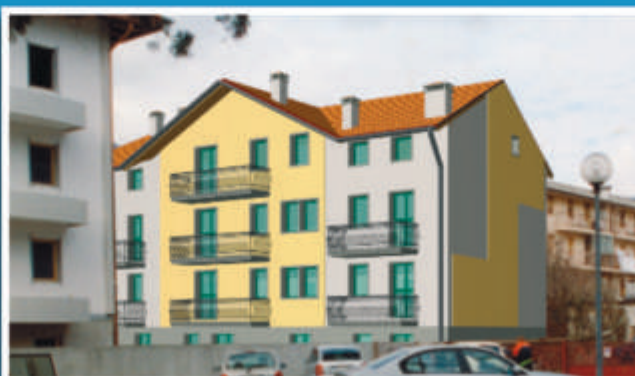
TOLMEZZO - prossima consegna prestigiosi appartamenti 1-2 camere, finiture personalizzabili, ottimo isolamento termico/acustico. IMMOBILIARE ALPE ADRIA 0433/41010
